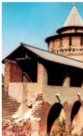
Ил. 9. Коломенский кремль. Аркада с тыльной стороны в процессе реставрации. Вдали — Коломенская (Маринкина) башня. Фото 1975 г.
