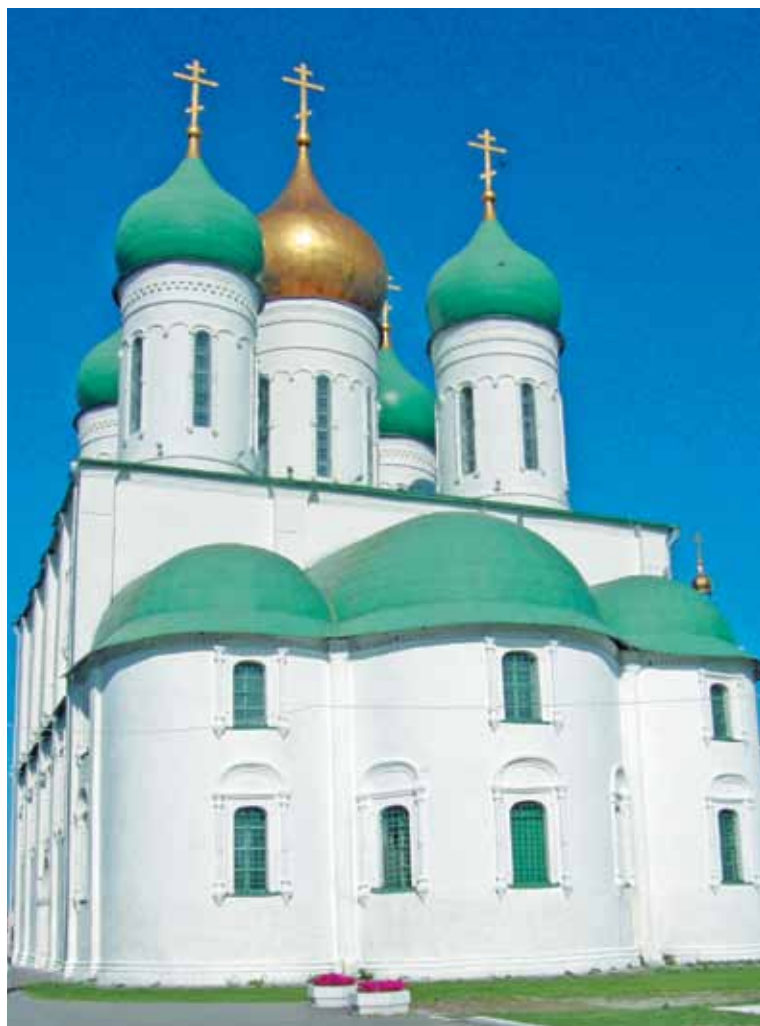
Ил. 7. Вид с юго-востока на Успенский собор в Коломне.
