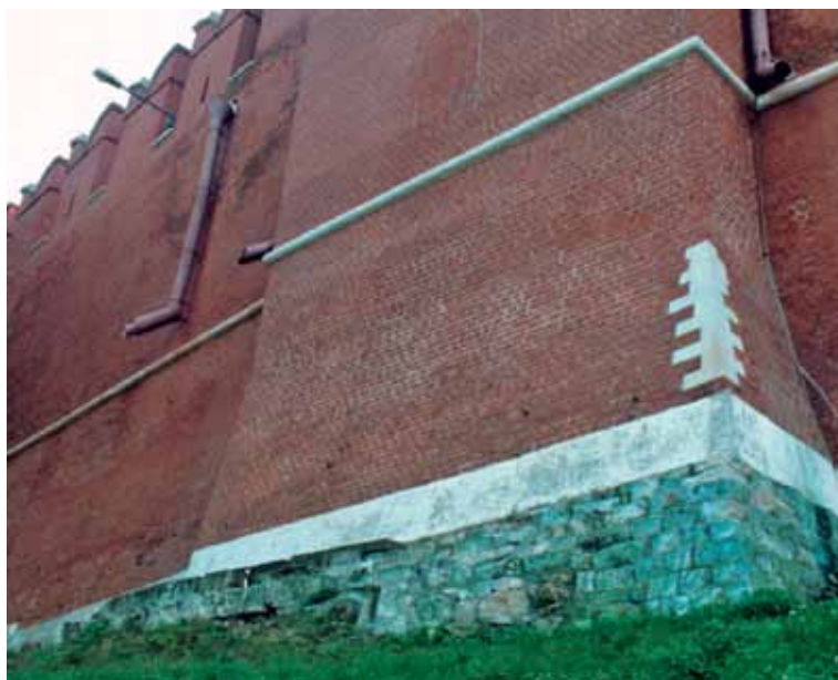
Ил. 5. Московский Кремль (1485 – 1495 гг.). Белокаменное основание Оружейной башни и примыкающих к ней прясел. Фото 2001 г.
