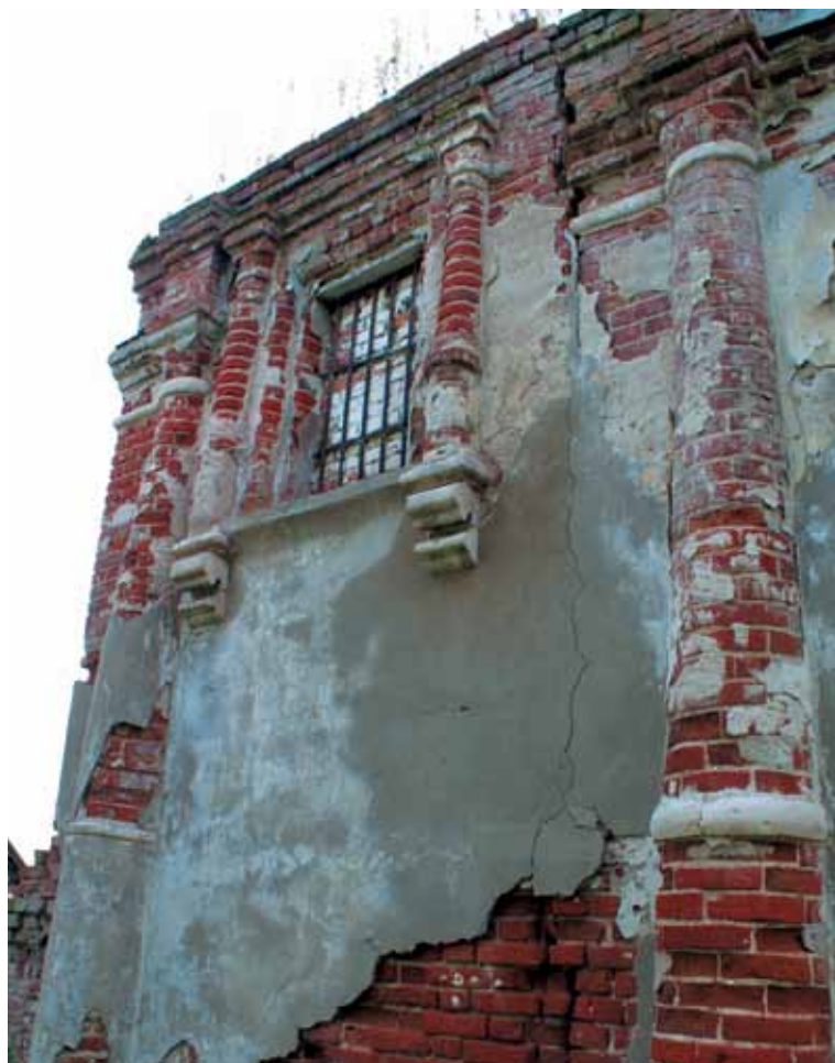
Ил. 3. Окошко в небольшом приделе с хорошо видными типичными для барокко белокаменными кронштейнами.
