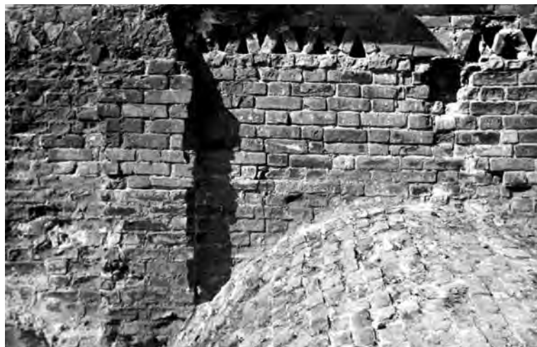
Ил. 22. Северная сторона стены алтарной части.
