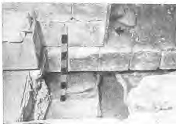
Рис. 7. Шурф 23. Фундаментное основание южной стены подклета и юго-западного пристенного столба
